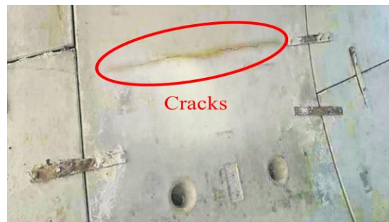
(d) Cracks on lining
