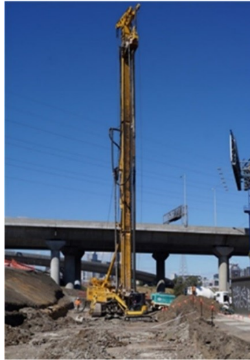
Figure 3.11. Mait HR 360-800 piling rig
