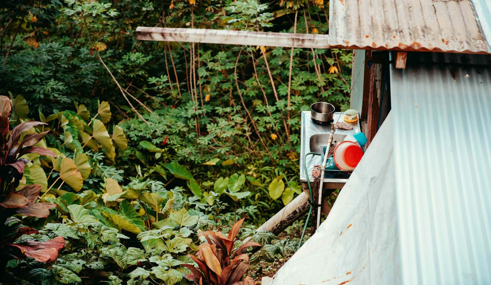
Gambar 1: Sebuah wastafel dapur dengan sebatang penyangga pada sebuah jendela rumah di Suva, Fiji. Pipa pasokan air menggunakan polypipe tipis yang rapuh, dengan air limbah disalurkan ke area perkebunan di bawahnya. (Program RISE)
